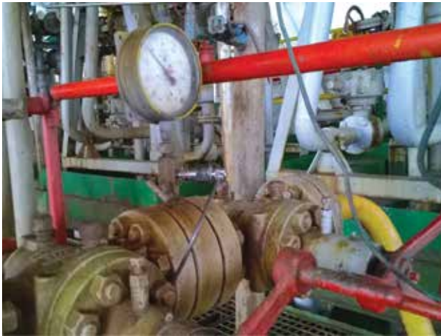
Hình 3. Vị trí lắp đường bơm hóa phẩm vào đường khí gaslift.
